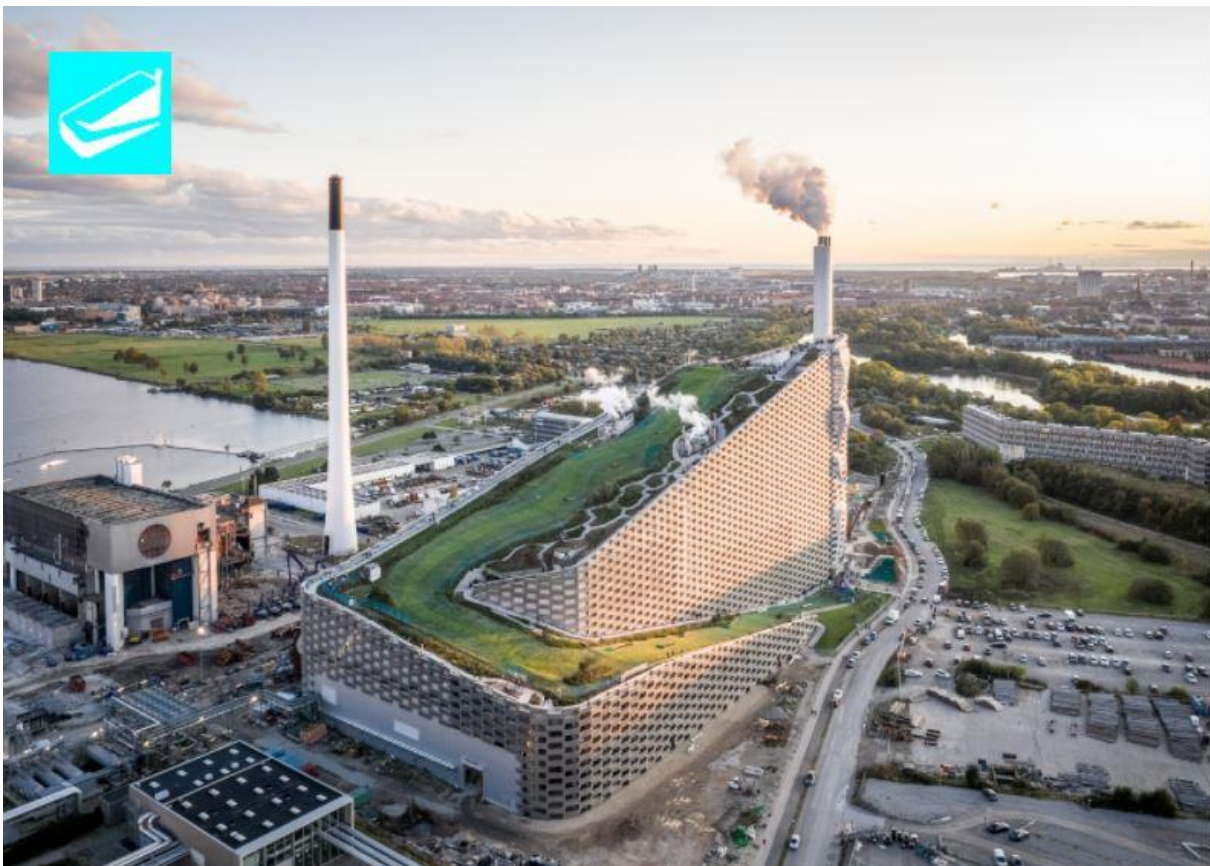
Die Müllverbrennungsanlage und Skipiste „CopenHill“/Quelle: GROßE/ Bjarke Ingels Gruppe
